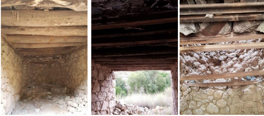
Fotoğraf 8. Aksu kireç ocakları- araba yolu tüneli-ocakaltı ızgara demirleri
