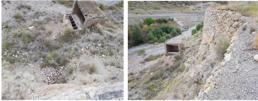
Fotoğraf 18. Aksu kireç ocakları- Yükleme rampası-ocaküstü
