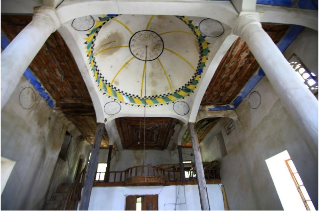
Fotoğraf 14. Üçköy Köyü Camii, düz ahşap tavan ve merkezde destekli bağdadi kubbe, Mayıs, 2018, Sabri Çiçekçi
