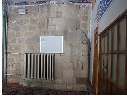
Resim 7. Gürün Ulu Camii kuzey cephesinde minare kaidesi
