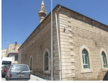
Resim 4. Gürün Ulu Camii güneybatıdan görünüşü
