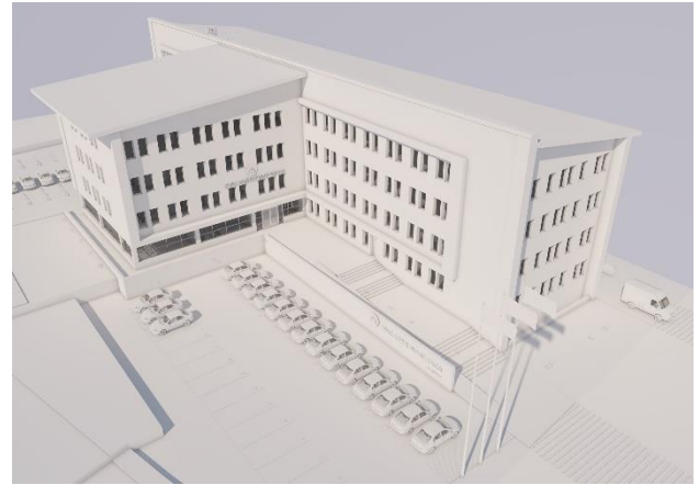
Şekil 1. Hınıs Adliye Binası Esas Giriş Cephesi
