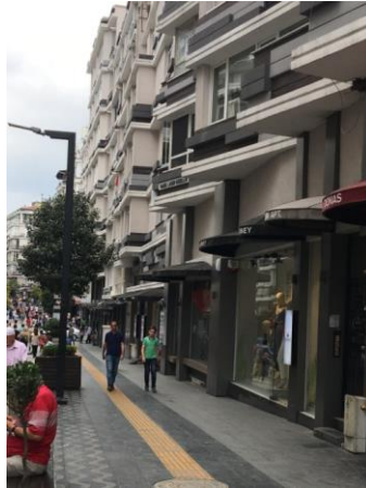
Şekil 9. Caddedeki binaların zemin kat cepheleri
