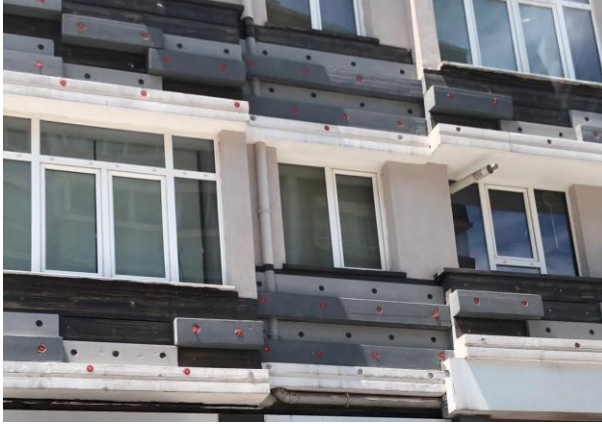
Şekil 15. Yenilenen bina cephelerinde onarım yapılması
