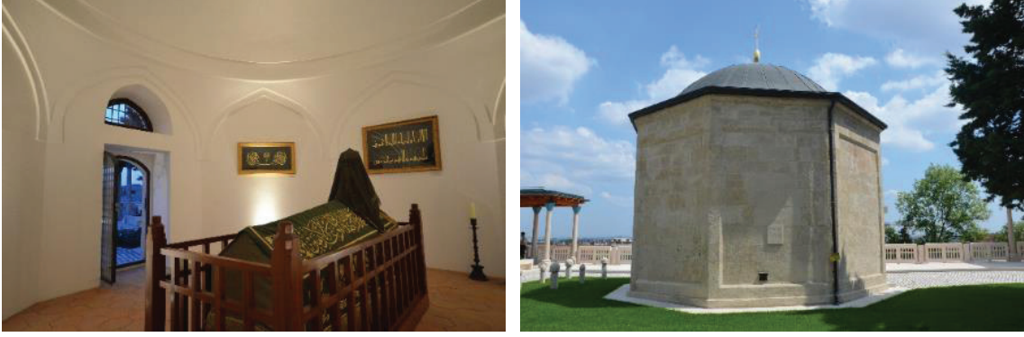
Resim 10-11. Onarım sonrasında Gül Baba Türbesi (2018)
