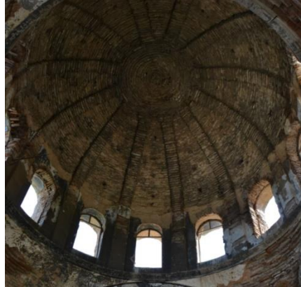
Resim 3. Kumyaka Başmelekler Kilisesi, Kubbe, Kuzeyden Güneye Bakış
