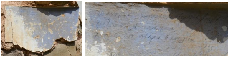
Resim 39. Kumyaka Başmelekler Kilisesi, H Mekanının (Giriş Mekanı) Kuzeyindeki Duvarlar, 1965 Tarihli Yazı
