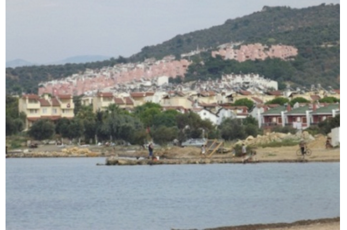
Fotoğraf 3. İkinci konut yapılaşmasından görseller (Ceylan©) Photo 3. Second homes built in coast area of Pelitköy
