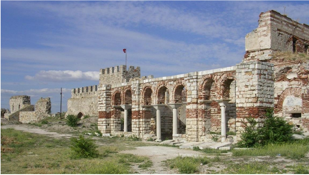
Fig. 8 Kilisenin galerili batı cephesi (exonarthex) (H. Günözü)
