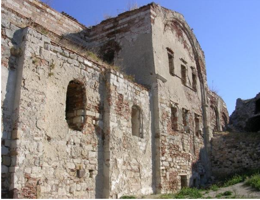
Fig. 14 Güney cephe (H. Günözü)
