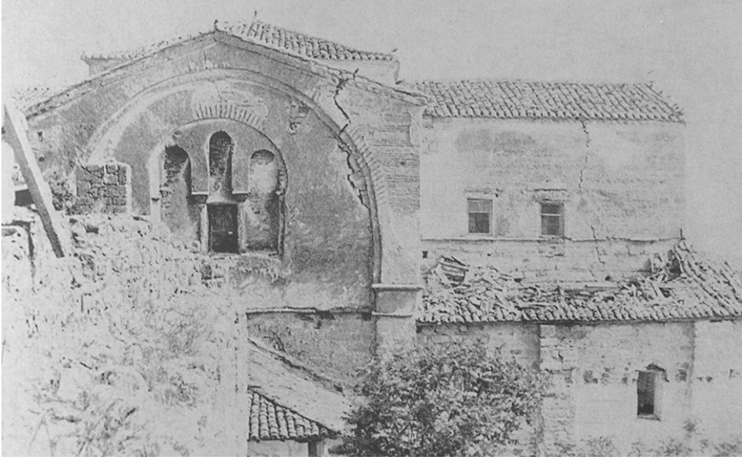
Fig.3 Enez Ayasofya Kilisesi'nin kuzey cephesi (S. Eyice 1961-1962)
