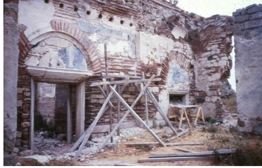
Fig. 24 Kilisede 1993 yılında yapılan çalışma sonunda ortaya çıkartılan Bizans dönemi duvar resimleri (İ. Tunay)
