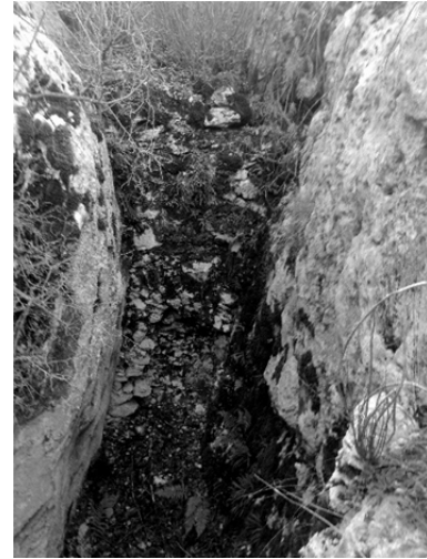
Fig. 4. Sarnıç Güney Duvarı
