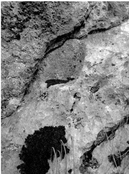
Fig. 6. Doğu Duvarı Üzerindeki "Yuva"
