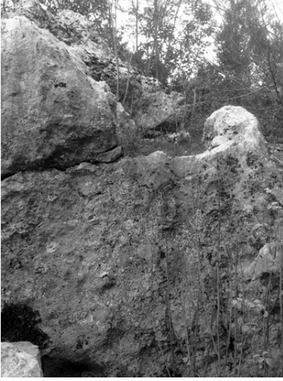
Fig. 7. Batı Duvarı Üzerindeki "Yuva"
