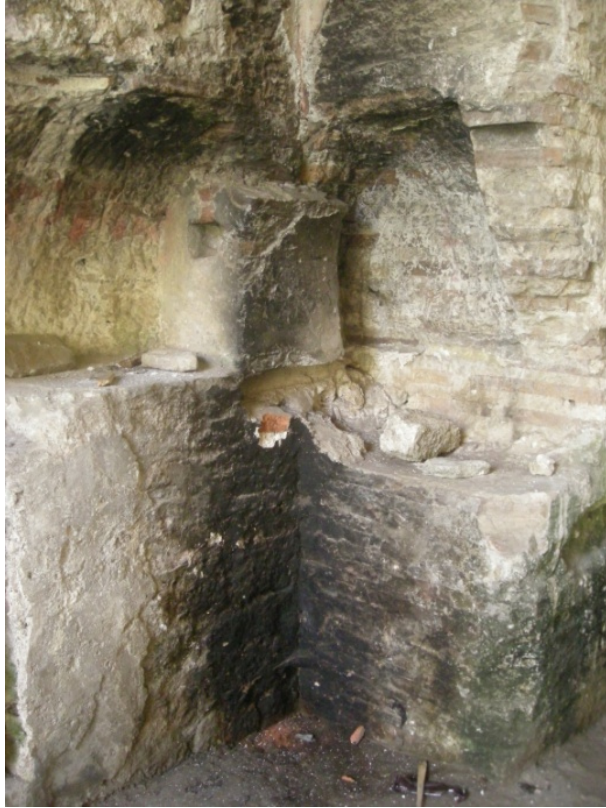
Fig. 8 Yapıda yakılan ateş sonucu oluşan is tabakası. Hande Günözü.
