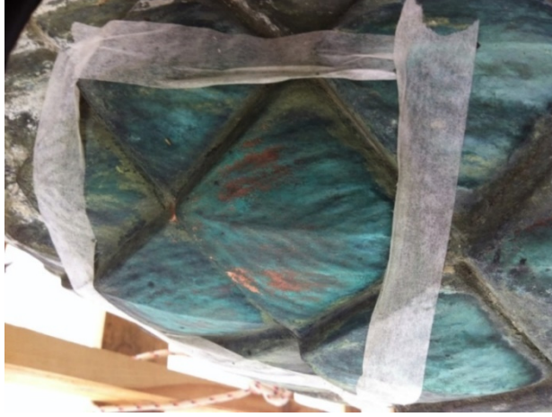
Fig. 9 Alman eşmesi'nin metal kubbesinin alt kısmında konservasyon uygulamaları denemeleri. (S.Tulgar).
