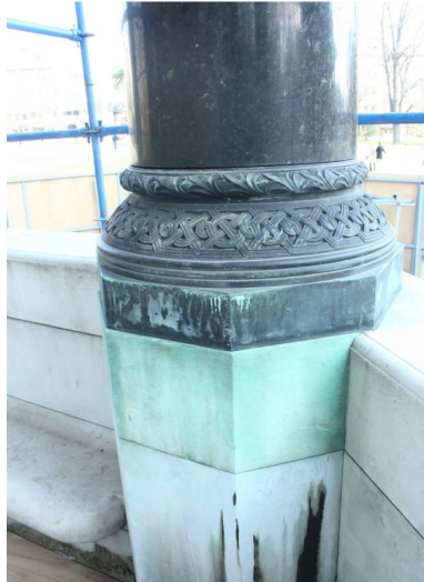
Fig. 11 Alman eşmesi'ndeki metal sütun bileziklerinin konservasyon uygulamaları öncesi (S.Tulgar).
