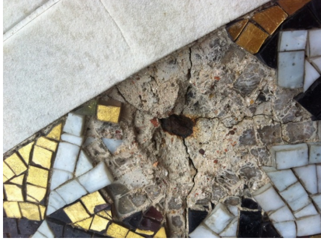
Fig. 13 Alman Çeşmesi'ndeki metal kenetlerin konservasyon uygulamaları öncesi (S.Tulgar).
