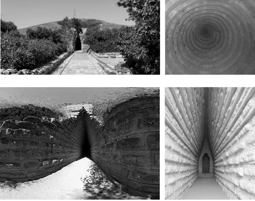
Fig. 17 Dromoslu katakomp kurgan örneđi, Kerch kurganı (Kraliyet Kurganı), yük. 20 m. çap: 80 m., kireç taşından bindirme tekniğinde yalancı kubbeli kare planlı ahşaptan mezar odası (4.39 x 4.35), yük.8. 84 m., kireç taşından dromos gen. 2.80 m. uz. 37 .m, İskit dönemi, M.Ö. 4. yüzyıl, Ukrayna.
