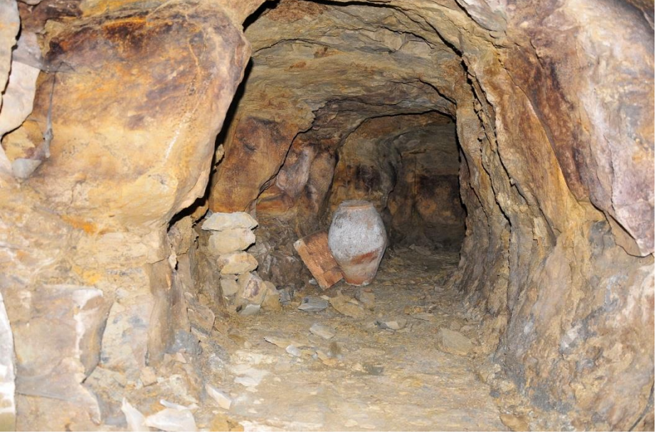
Fotoğraf 18. Hacı Sadık Ağa Hamı Zemin Kat Kaya Oyma Su Kanalı
