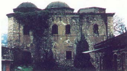
Fot.11 : Lengerhane Restorasyondan Önce (Tasarım, 2001:51)
