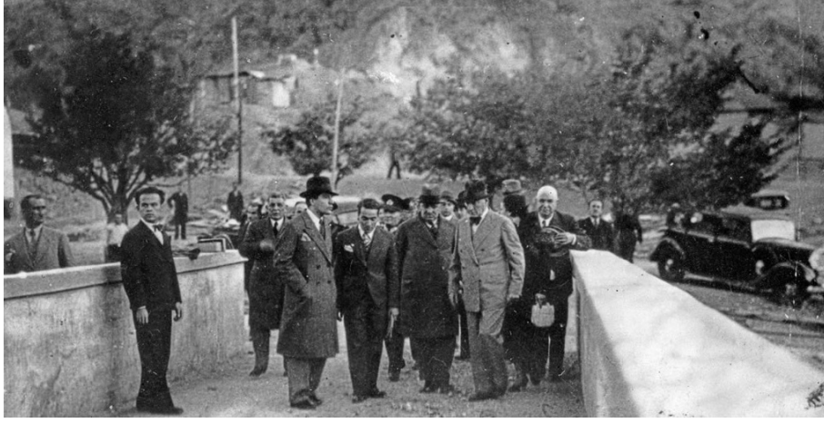
Atatürk, Çubuk Barajı'nda incelemelerde bulunurken 76
