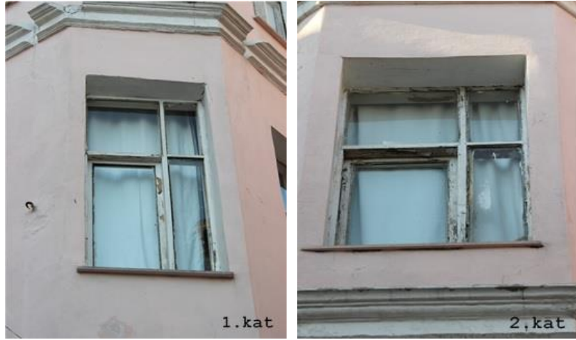
Şekil 8. 7 nolu konutun 1. ve 2. katlarındaki köşe duvar üzerindeki pencereler [26]
