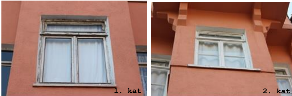
Şekil 9. 6 nolu konutun 1. ve 2. katlarındaki köşe duvar üzerindeki pencereler [26]
