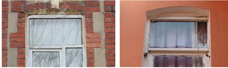
Şekil 12. Kasa ile kemer arasında boşluk bulunan pencereler (Figure 12. Windows with a space between the frame and the arch)
