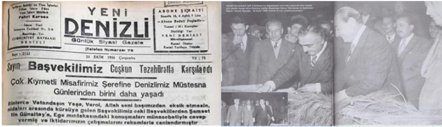
Şekil 4. Denizli Sümerbank İplik Fabrikası'nı ek bina için yapılan temel atma töreni, 22 Eylül 1956 (Kaynak: Yeni Denizli Gazetesi Arşivi; İnan, 2007, s.32-33)
