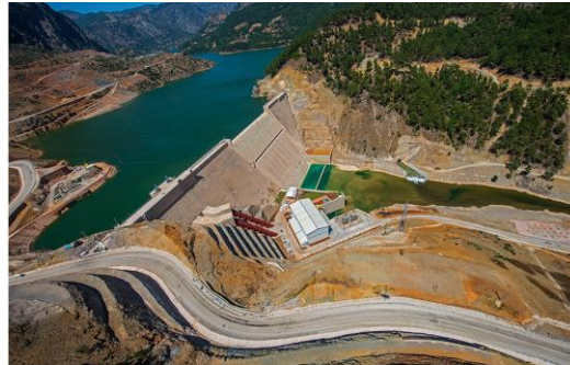
Şekil 1. Köprü Barajı inşaatının tamamlanmış hali (Özaltın, 2019)
