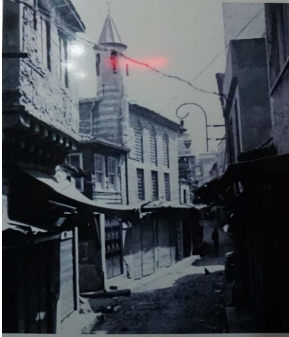
Şekil 8. (Solda) Hacı Timurtaş Mescidi (Cami girişinde duvarda asılı fotoğraf, tb)
