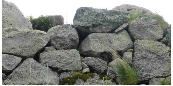
Fotoğraf 3- Gölge Güneybatı Kalesi duvar işçiliğinden ayrıntı.
