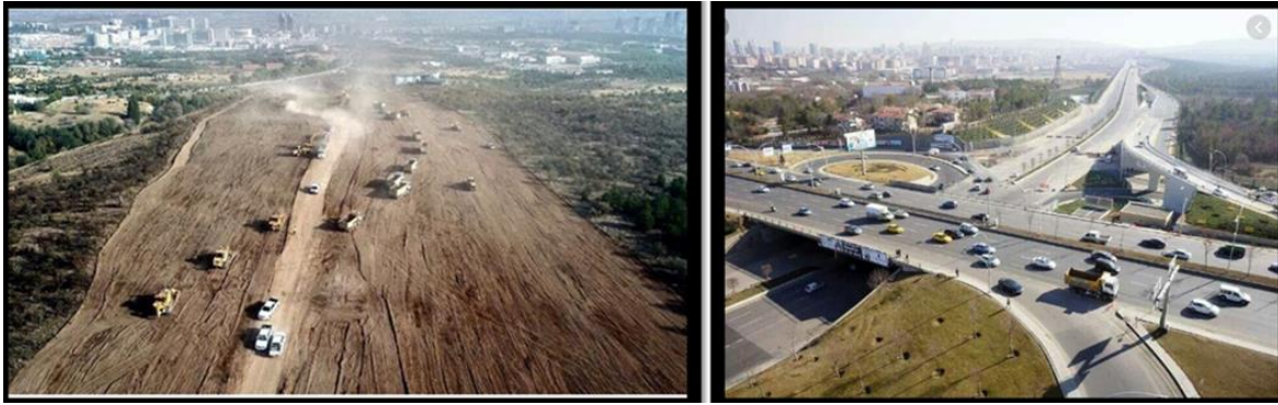
Şekil 9: ODTÜ Arazisinin Dönüşümü. Kaynak:URL- 2)
