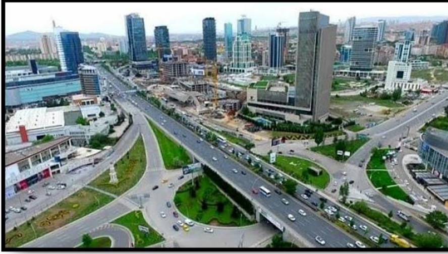
Şekil 3: Eskişehir Yolu Genel Görünüş. Kaynak: (URL - 1)
