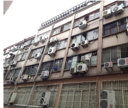
Şekil 26: Konut yoğunluğunu azaltan iş hanı yapısı Kaynak: Can Bulubay Arşivi
