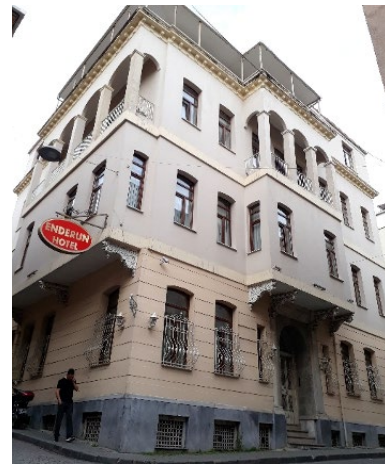
Şekil 32: Eski Gedikpaşa Amerikan Okulu binası Kaynak: Can Bulubay Arşivi
