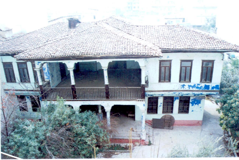
Resim 3: Konağın Ön Cephesi
