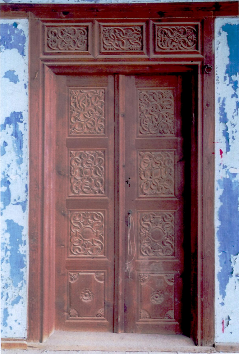
Resim 7: Üst Kat Kuzeybatı Oda Kapısı
