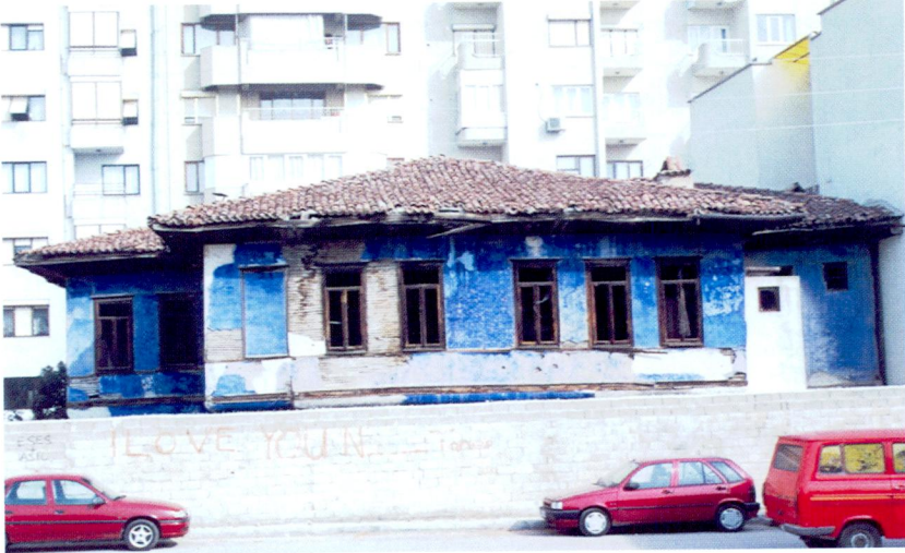
Resim 4: Konağın Arka Cephesi
