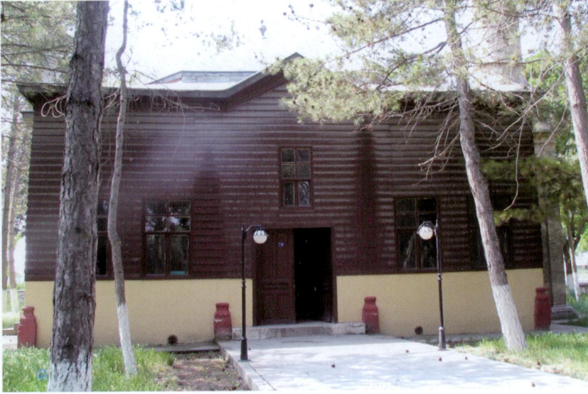
Resim 10: Mahmudiye Hara Camii – giriş cephesi
