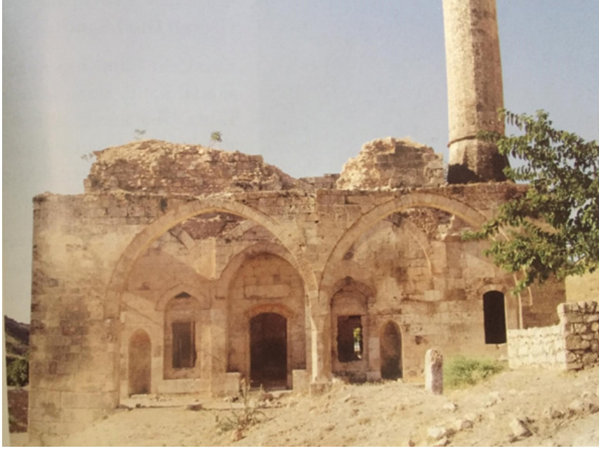
Resim 1: Zeyrek Ağa Camisi Restorasyon Öncesi Durumu (Giriş Kısmı) (Zeyrek vd. 2006: 125).
