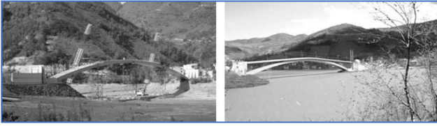
Şekil 3: İnşa Süresince ve İnşadan Sonra Samsun Ayvacık Köprüsü [10]
