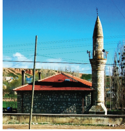
Fotoğraf 12: Kuzey cephe
