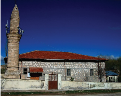
Fotoğraf 10: Batı cephe
