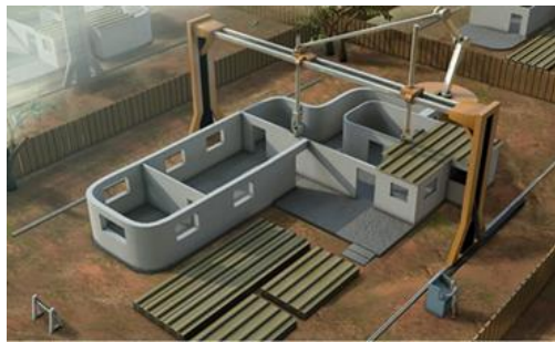
Resim 1: Kontur üretimi sistemi, vinç uygulaması (Gaget, 2018).
