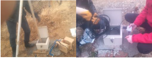
Şekil 4. Nem sensörlerinin kuyu montajı
