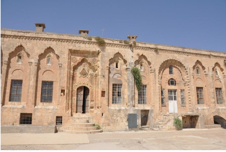
Resim 7. Dokmaklar Evi, İkinci Kat, Güney Cephesi (Fotoğraf yazar tarafından çekilmiştir, 2015).
