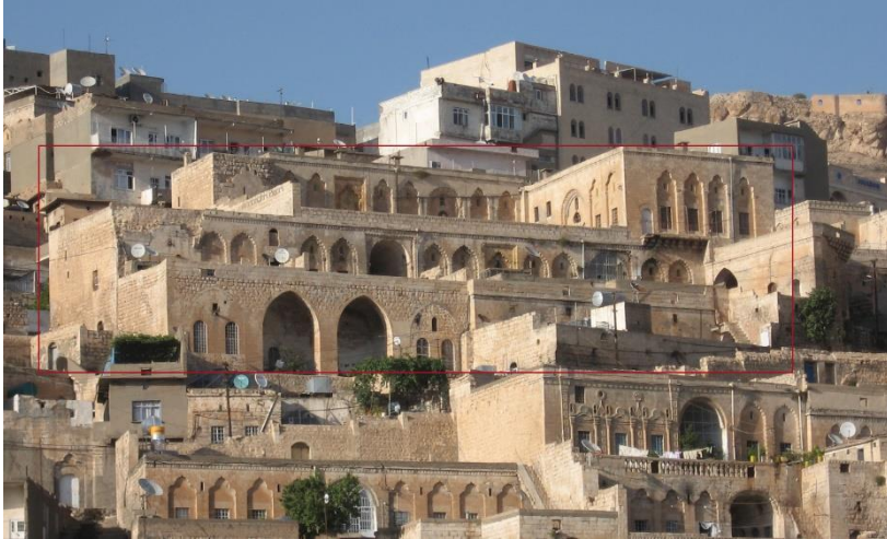
Resim 6. Dokmaklar Evi, Genel Görünüş (Fotoğraf yazar tarafından çekilmiştir, 2015).
