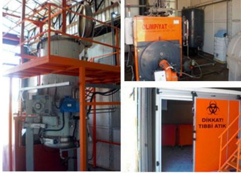
Şekil 2.2. Elazığ İli Sterilizasyon Tesisi [18, 20]
