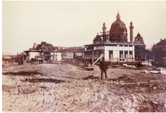
Şekil 27 Karlsplatz istasyonu inşası
