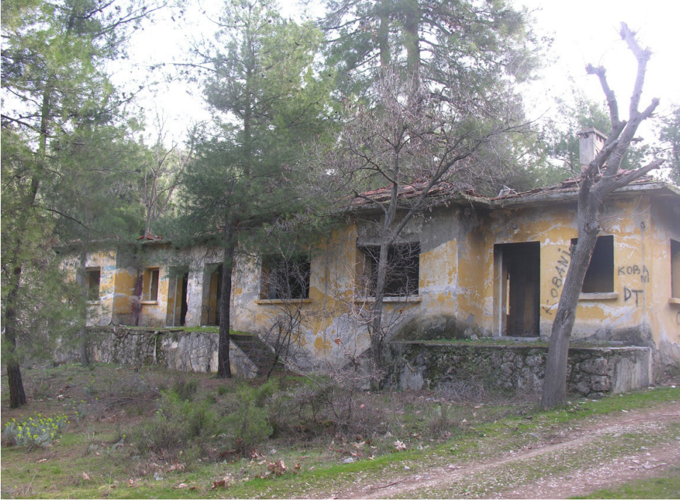
Gökpınar II Hidroelektrik Santral Binası Loljmanları (8 Şubat 2018)
