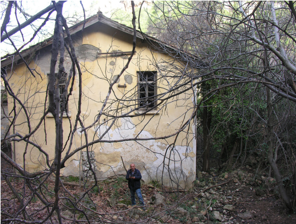
Gökpınar I Hidroelektrik Santral Binası - Arkadan Görünüş (8 Şubat 2018)
