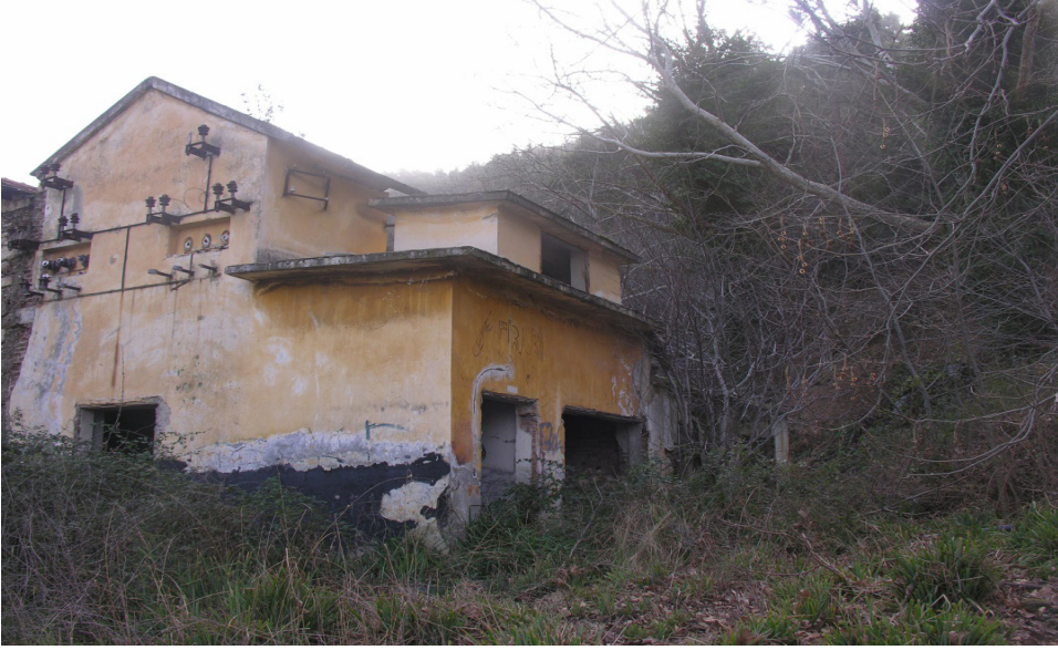
Gökpınar I Hidroelektrik Santral Binası - Önden Görünüşü (8 Şubat 2018)
