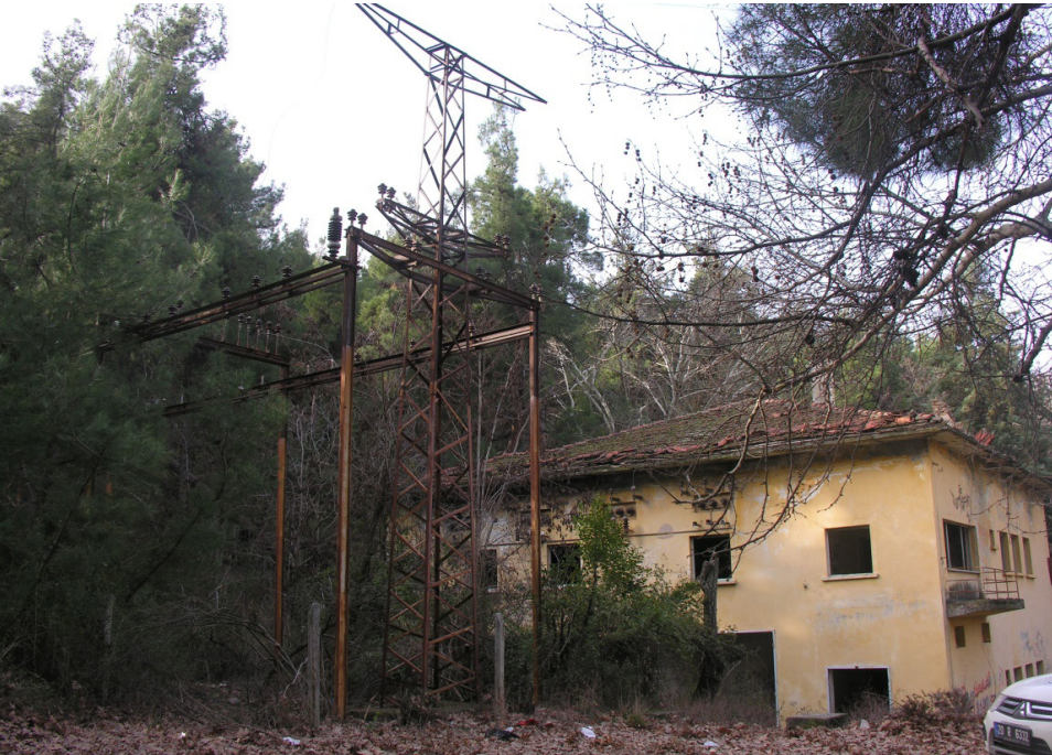
Gökpınar II Hidroelektrik Santral Binası Arkadan Görünüşü ve Trafosu (8 Şubat 2018)
