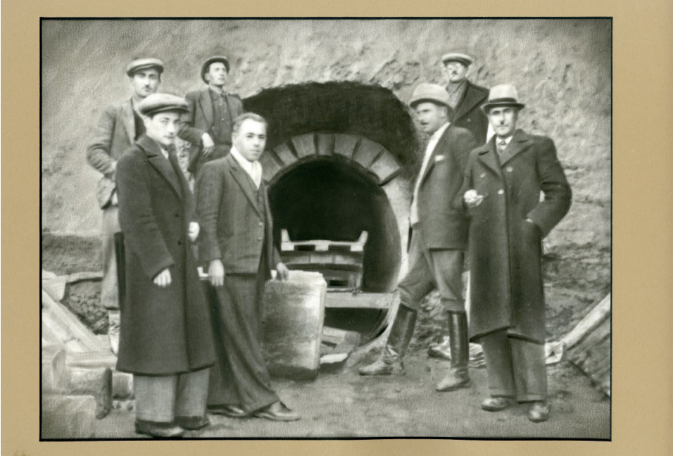
Tünel Girişi (Sağ Öndeki Belediye Başkanı Hüsnu Örnek, sağ ortada çizmeli Mehmet Dağdelen (Müteahhit), Sağ arkada Baki Bey (Kör Baki) Bayındırlıkta görev yapmıştır. Solda paltolu önde Kazım Değirmenciler (Mehmet Dağdelen'in yeğeni. İnşaatta çalışmıştır. Diğer üç kişi tespit edilememiştir)
