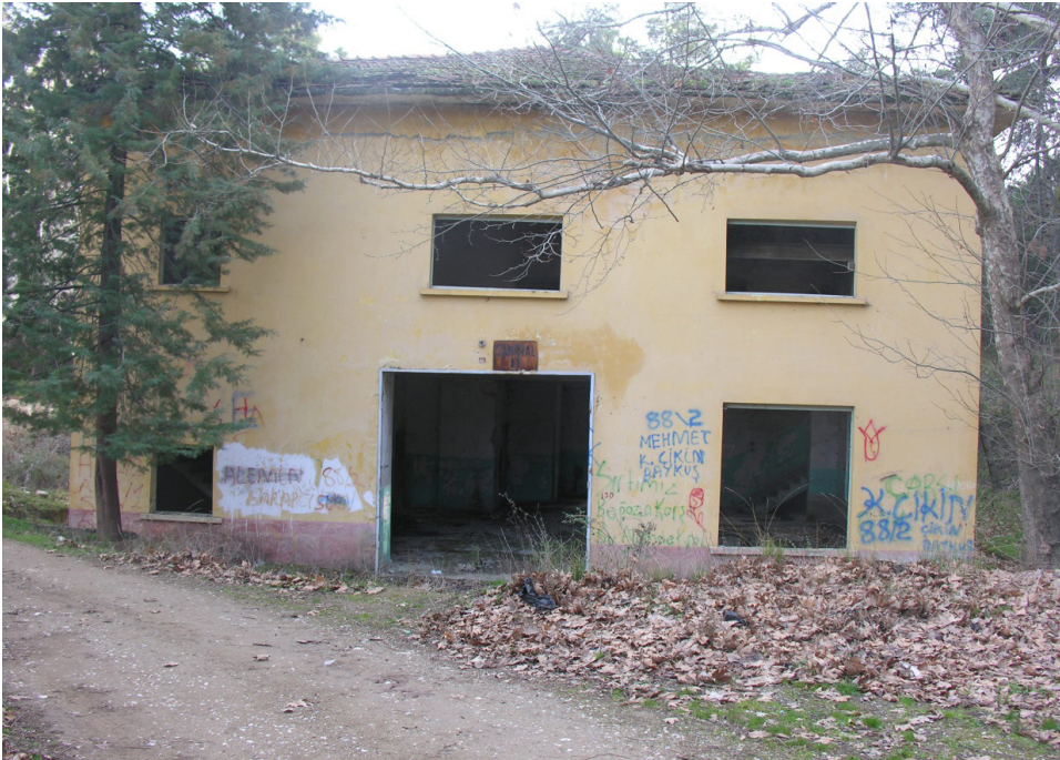
Gökpınar II Hidroelektrik Santral Binası Önden Görünüşü (8 Şubat 2018)
