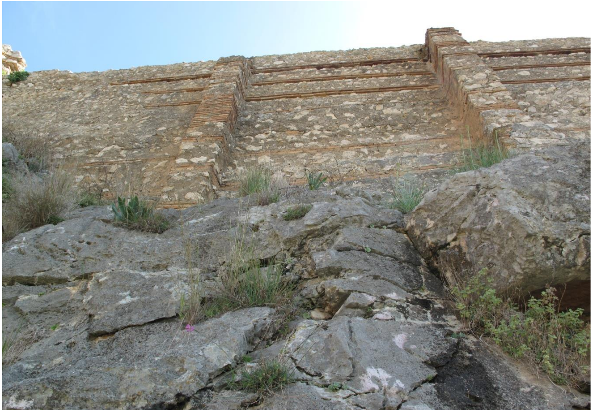
Şekil 10, İki Payandalı Sur duvarı
