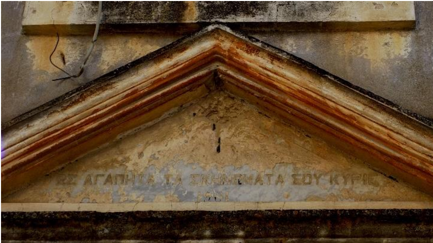
Şekil 19: Hagios Apostolos Kilisesi (Kilise Camii) batı cephesi giriş kapısı üzerinde yer alan kitabe
