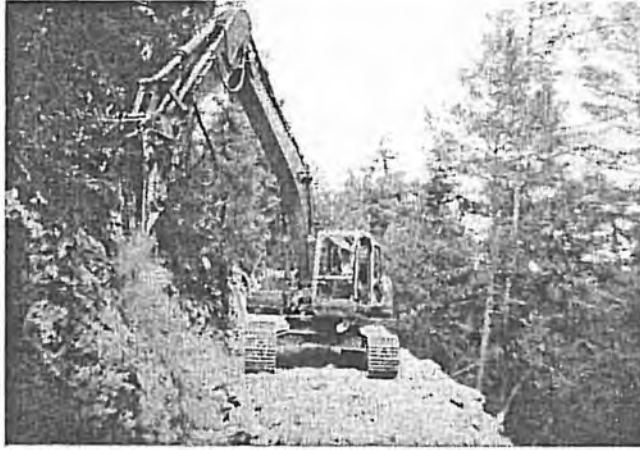
Figure 4. Constructing the subgrade by an excavator (Photo: T.Ozturk) Şekil 4. Bir ekskavatör ile yol temelini yapılması
