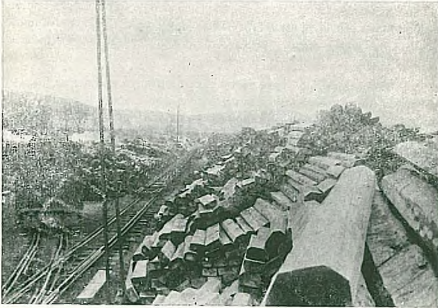
Resim 2 : Traverslerin kuruması ve mantar enfeksiyonuna karşı korunması için müsait olmayan bir istif şekli.
