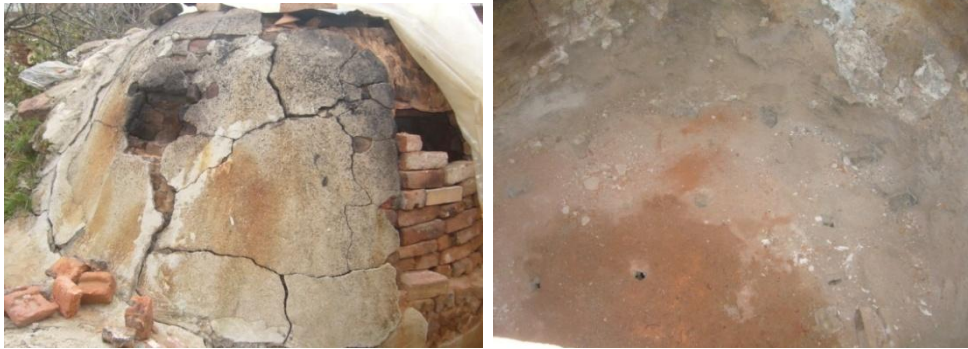
Şekil 4: H. Çokan'a ait fırının tuğla örülü açıklığı ve ızgara bölümü Kaynak: Fotoğraf Sevcan Ölçer, 2011
