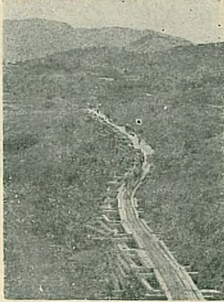
Resim 10a. Yarı işlenmiş keresteyi dereye götürmek için yapılmış bir oluk. Foto : Alaçam
