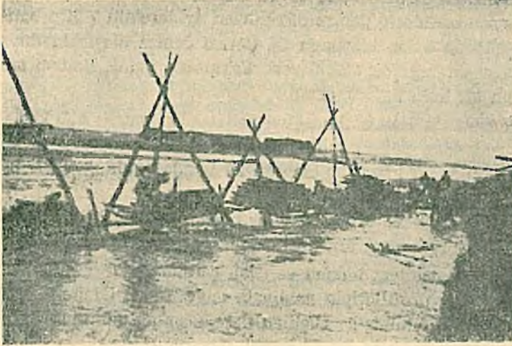
Resim 4. Eski Pazarderesi üzerinde yakacak kızılbaş odunu tutmak için kurulmuş bir ızgara. Ayakların sahanlığındaki odunlar ağırlık temin etmek maksadıyla konmuştur. Izgaranın karaya değen köşesinden odunlar dışarıya elle atılmaktadır. Foto : Alaçam
