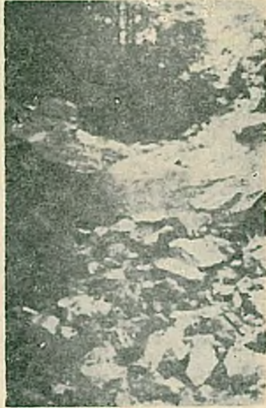
Resim 5. Pamuk Gölü şutunun alçaltılmasında kayaların dinamitle atılmasından elde edilen taşlar tabandan itibaren şivli bir şekilde yığılarak suyun akışı meyillendirilmiştir.
