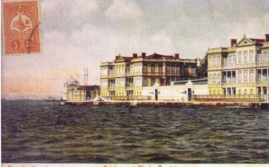
Resim 3. 1870'lerde, Ortaköyde Sultan Abdülhamit Tarafından, Kardeşi Sultan Reşad'ın Kızları Fehime, Fatma ve Hatice Sultanlar İçin Yaptırılan Birbirinin Benzeri Yalılardan İki.
