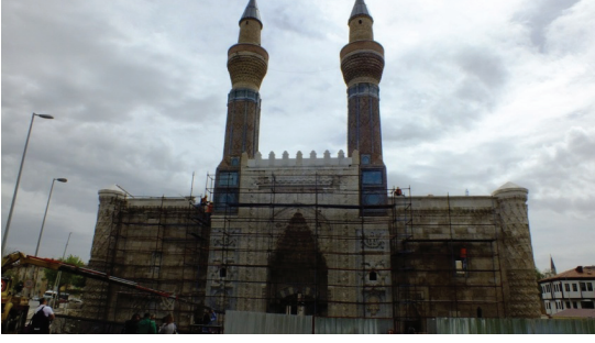
Sivas Gök Medrese Giriş Cephesi
