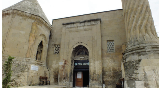
Amasya Burma Minareli Cami Giriş Cephesi
