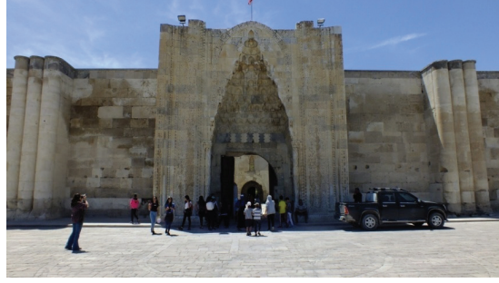
Aksaray Sultan Hanı Taçkapısı
