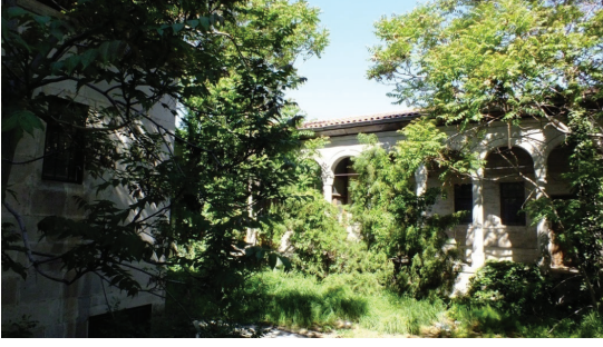
Aksaray Bedriye Medresesi Avlu ve Revaklar
