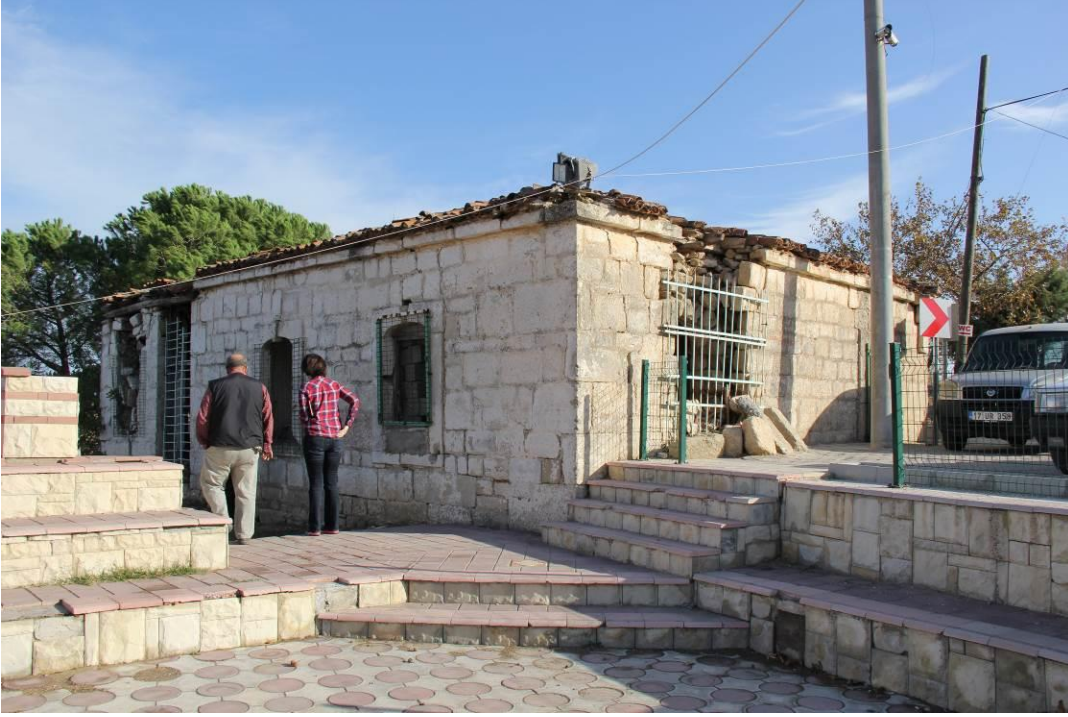
Res.29- Tevfikiye Köyü Camii, onarımdan önce.
