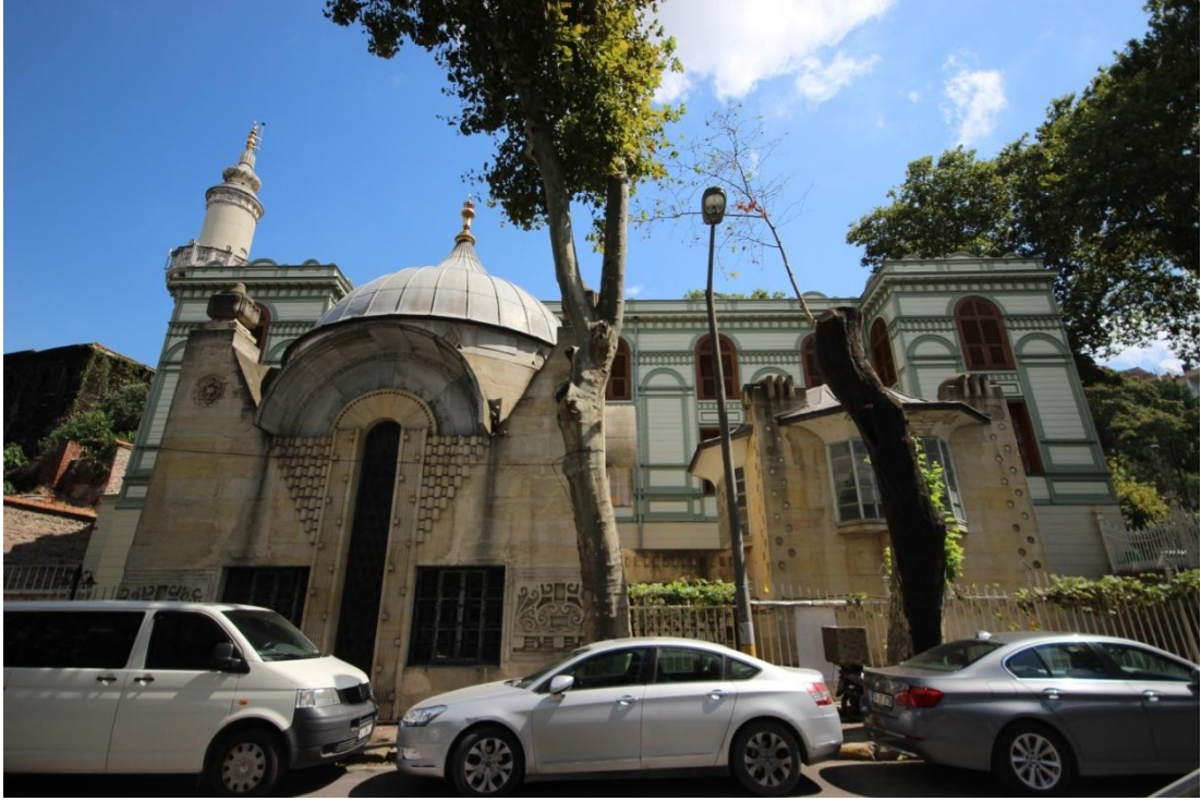
Resim 5: İstanbul, Beşiktaş, Ertuğrul Tekke Camii Batı Cephesi.
