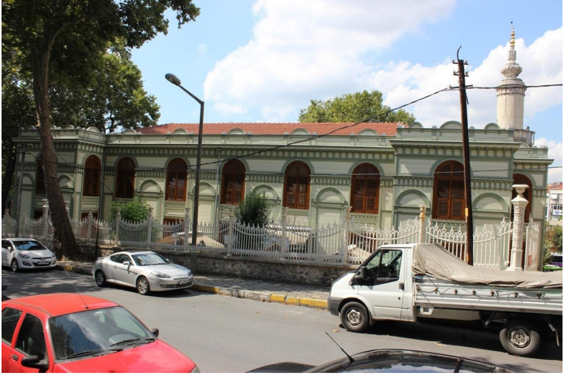
Resim 11: İstanbul, Beşiktaş, Ertuğrul Tekke Camii Doğu Cephesi.
