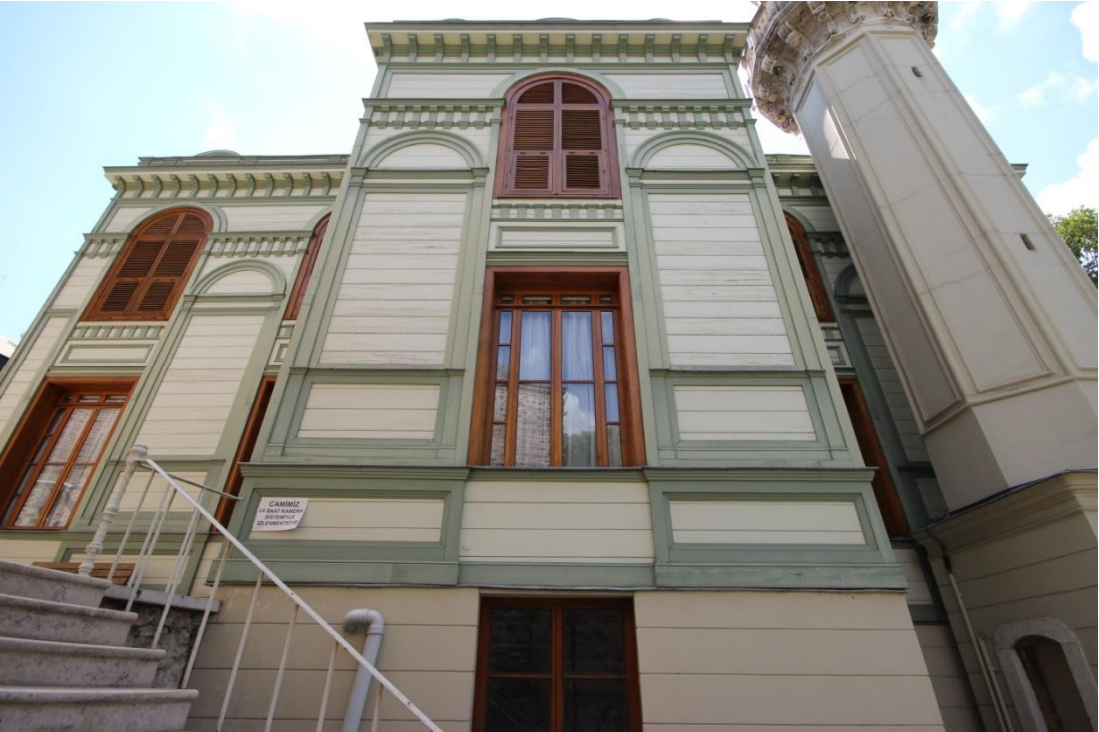
Resim 4: İstanbul, Beşiktaş, Ertuğrul Tekke Camii Kuzey Cephesi.
