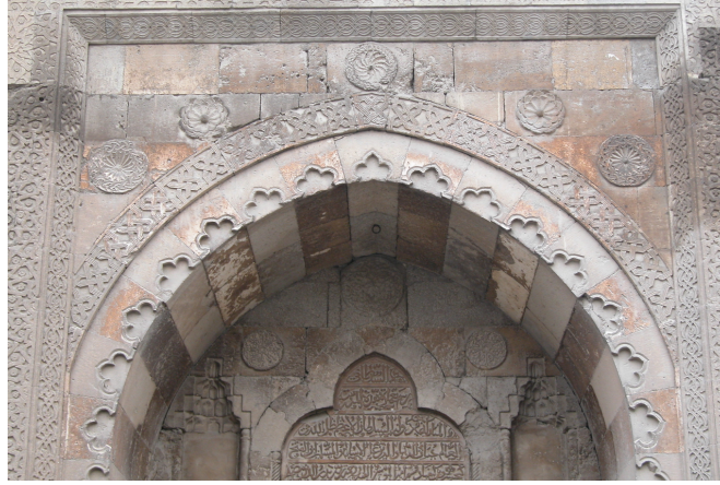
Görsel 10. Konya Sırçalı Medrese Taç kapısı sivri kemerli tonoz bölümündeki kompozisyon-derz ilişkisi
