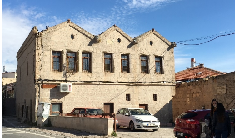
Fotoğraf 11. Aksaray Üniversitesi Güzelyurt M.Y.O. binası
