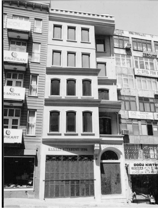
Şekil 7. Kanaat Kitabevi binası, ön cephe uygulaması (Çorapçioğlu, 2003).
