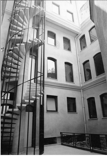
Şekil 8. Kanaat Kitabevi arka cephe.
