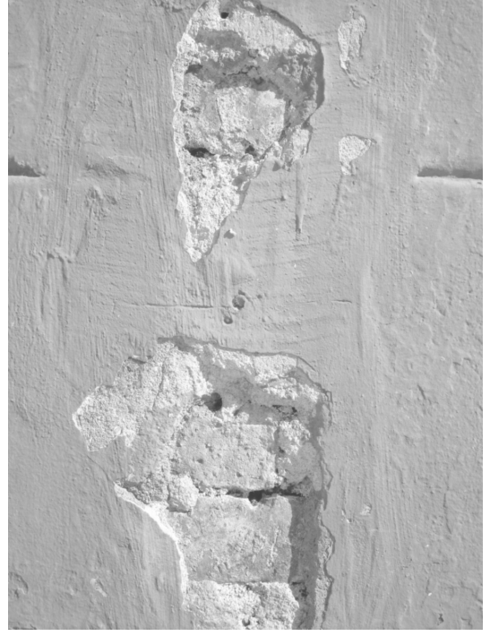
Resim 18: Duvarda örgü malzemesi ve tekniği
