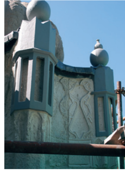
Şekil 34. Taş değişimi yapıldıktan sonraki görünüm
