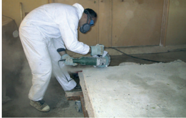
Resim 4. Çimentoların elmas uçlu diskler ile kesilmesi
