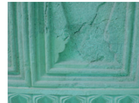
Şekil 32. Plastik onarım sonrası görünüm
