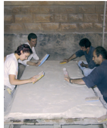
Resim 8. Mozaik yüzeyine tela yapıştırılması
