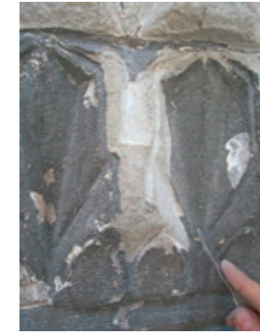
Şekil 29. Bezemeli yüzeylerde bisturi ile yapılan temizlik
