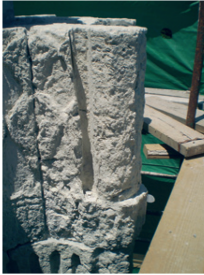
Şekil 33. Taş değişimi öncesindeki görünüm
