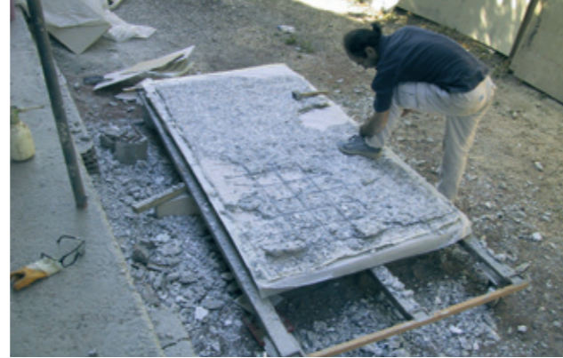
Resim 5. Çimentoların mekanik olarak temizlenmesi
