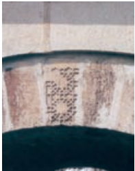
Resim 16. Köprü'nün kilit taşındaki geometrik bezeme
