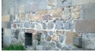
Şekil 4. Doğu cephesinde düzgün kesilmemiş taşlarla oluşturulan örgü
