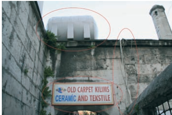
Şekil 40. Çorlulu Ali Paşa Camisi avlusunda su deposu, tabe, tesisat boruları, vb. eklentiler (İ.SAĞDİÇ; 2011)
