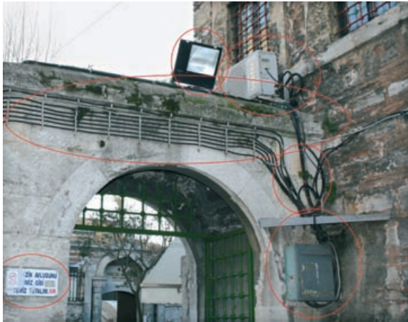
Şekil 55. Atık Ali Paşa Camisi, avlu kapısı ile birleşiminde bulunan tesisata ilişkin eklentiler
