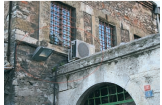
Şekil 53-54. Atık Ali Külliyesi'ne ait Muvakkithane - Sıbyan Mektebi, avlu giriş kapısı ile yapının bitiştiği noktada aydınlatma elemanları, anten, kablo ve klima eklentileri (İ.SAĞDIÇ; 2011)
