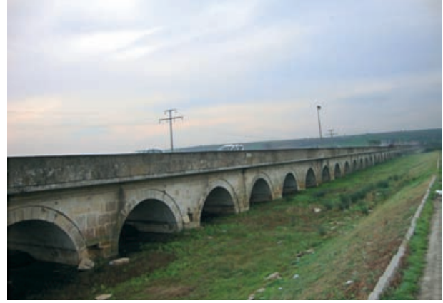
Resim 13. Kemer üzengi taşına kadar toprak altında kalan köprü'nün görünüşü
