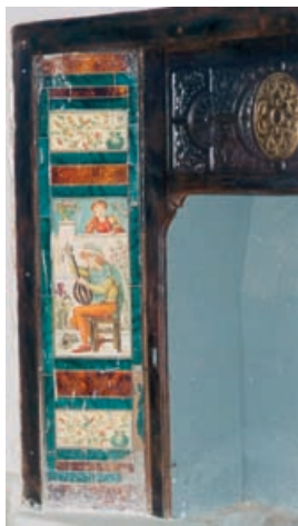
Resim-6: Toplantı odasındaki Şömine (detay) (Restorasyon Öncesi)
