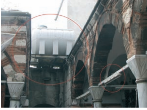
Şekil 42-43. Çorlulu Ali Paşa Camisi avlusundaki su deposu, aydınlatma elemanları, vb. eklentiler (İ.SAĞDIC; 2011)
