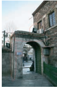
Şekil 53-54. Atık Ali Külliyesi'ne ait Muvakkithane - Sıbyan Mektebi, avlu giriş kapısı ile yapının bitiştiği noktada aydınlatma elemanları, anten, kablo ve klima eklentileri (İ.SAĞDIÇ; 2011)
