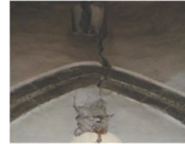
Şekil 7. Kemerlerin kilit taşı civarında meydana gelen hasar
