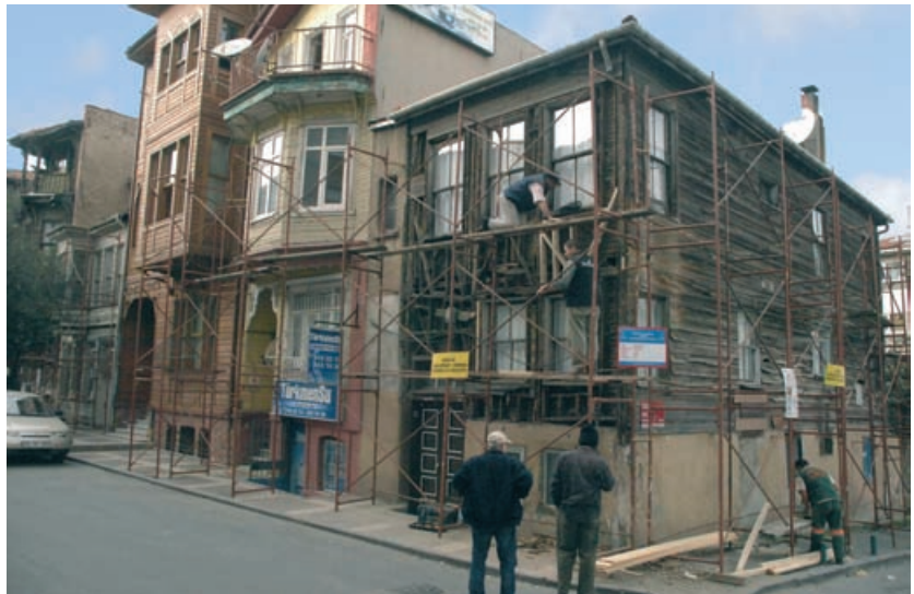
Ahşap yapılarda onarım başlangıcı-Cemil Meriç Sokak
