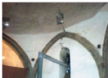
Şekil 6. Kubbenin alt kısmında meydana gelen açılmalar
