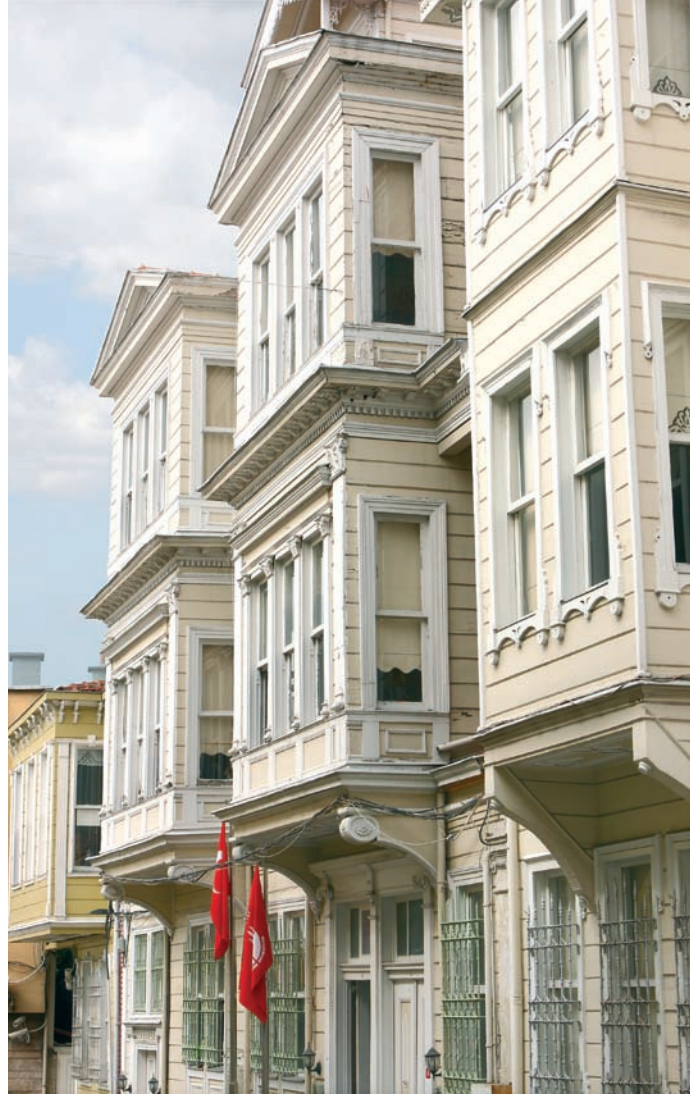
Süleymaniye'de KUDEB tarafından kullanılan Kayserili Ahmet Paşa Konağı, bakım-onarım kapsamında değerlendirilmiştir.
