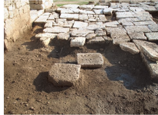
Resim 7. Yer döşemelerinin restorasyon çalışmaları
