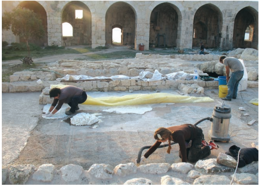
Resim 20. AB 57 ve kağıt hamuru ile yapılan temizlik çalışmaları
