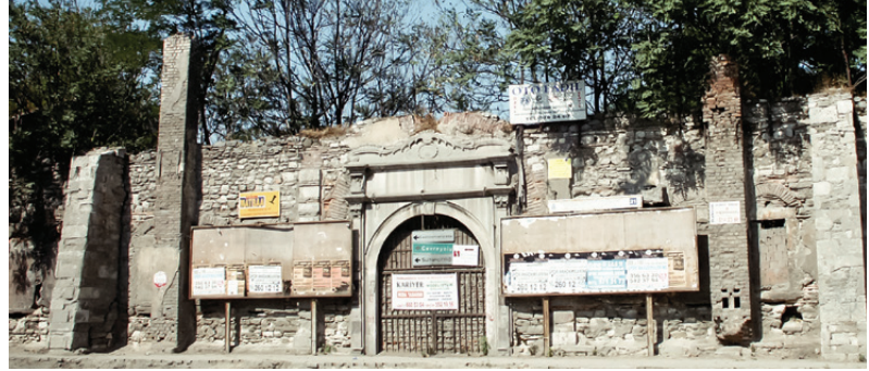
Şekil 6. Rami kışlası 2 no.lu anakol kapısı, Akant Mimarlık Arşivi, 2006.
