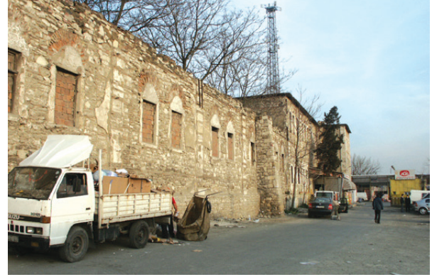
Şekil 15. Rami kışlası, 8 no. lu anakoldan görünüm, Akant Mimarlık Arşivi.
