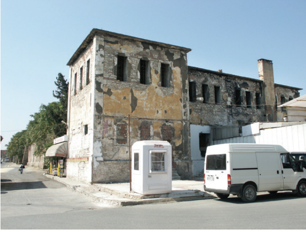
Şekil 12. Rami kışlası, 7 no. lu anakoldan görünüm, Akant Mimarlık Arşivi, 2006.
