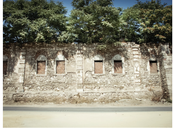
Şekil 11. Rami kışlası, 8 no.lu anakoldan görünüm, Akant Mimarlık Arşivi, 2006.
