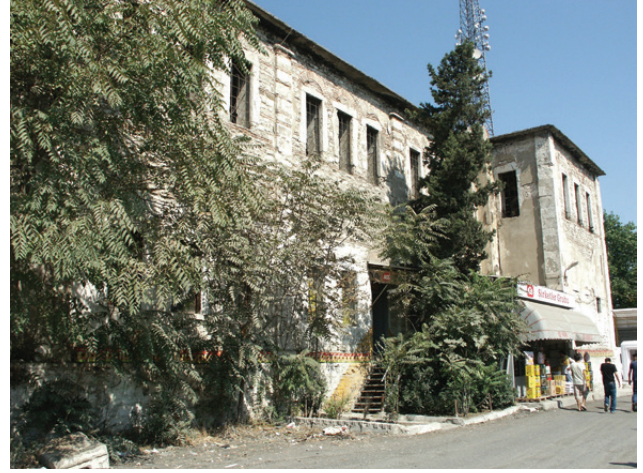
Şekil 13. Rami kışlası, 8 no.lu anakol köşesinden görünüm, Akant Mimarlık Arşivi, 2006.
