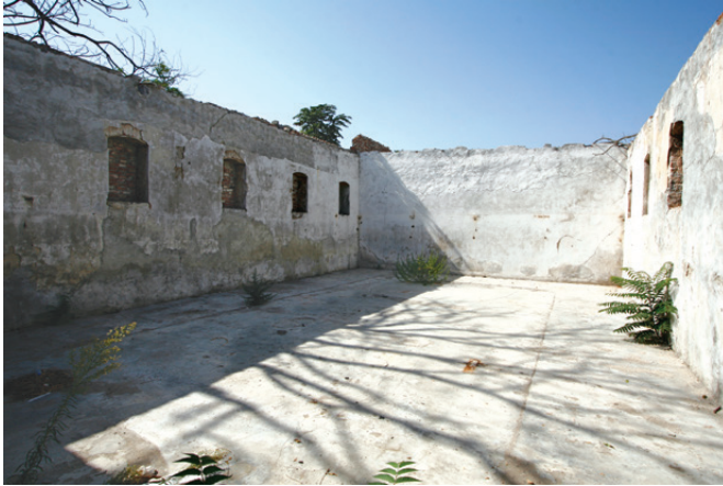
Şekil 10. Rami Kışlası avludan görünüm, KUDEB, 2010. Fotoğraf: Fatih Kocaisık
